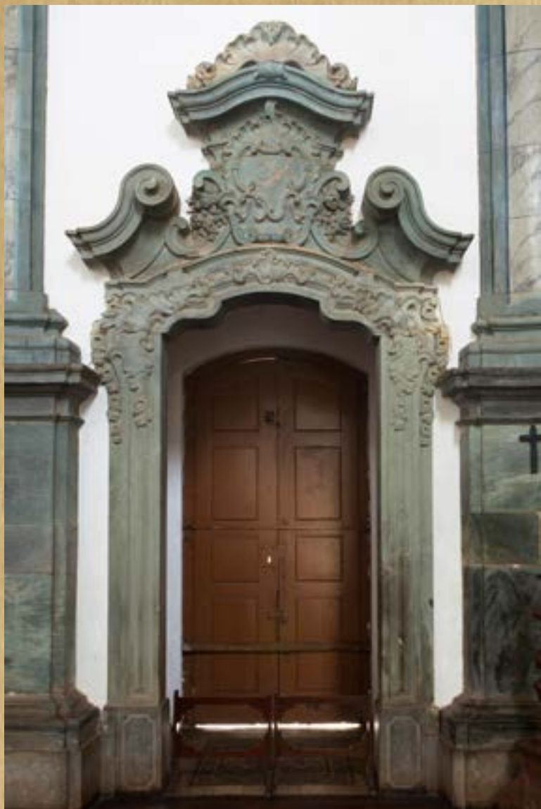
IMG 361 | Portada interna de entrada lateral
