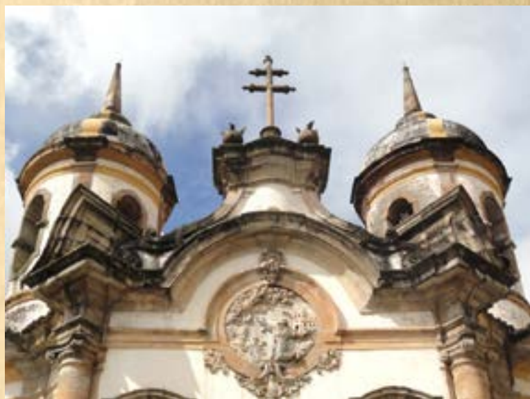
IMG 214 | Detalhe das torres
