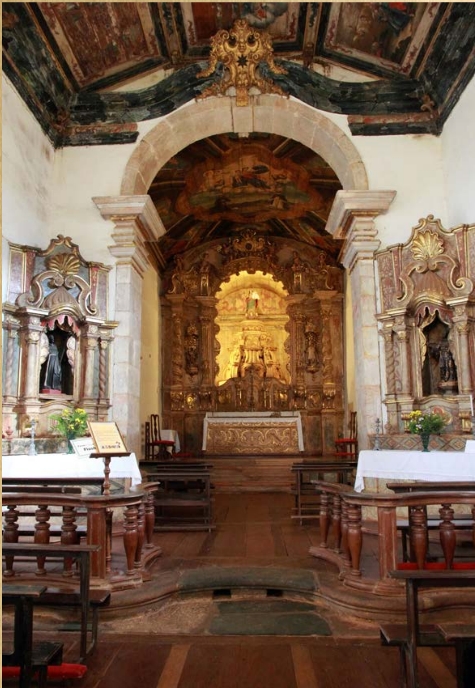
IMG 400 | Detalhes do forro da nave e das fendas de ventilação no piso (a porta principal nunca era aberta) | Altares colaterais, arco-cruzeiro e capela-mor
