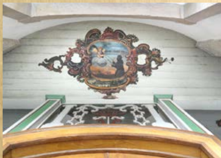
IMG 207 | Detalhe do teto na entrada da igreja
