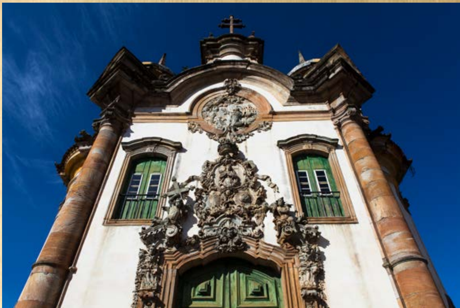
IMG 213 | Detalhes da frontão
